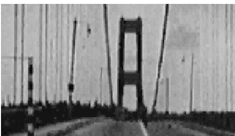
Abb. 1-4: Beispiel für einen instabilen Prozess: Einsturz der Tacoma Bridge (14.11.1940)
